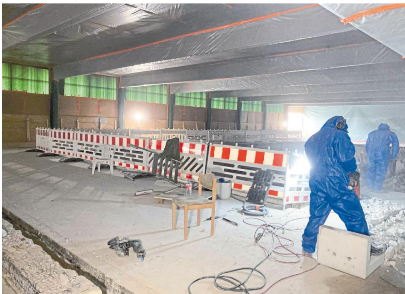
Die Beckenwände und der Boden werden entfernt.
