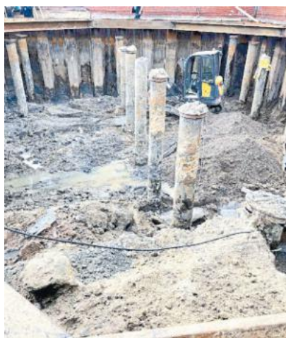
Ein Blick ins künftige Auffangbecken vor dem Schwimmbad.
